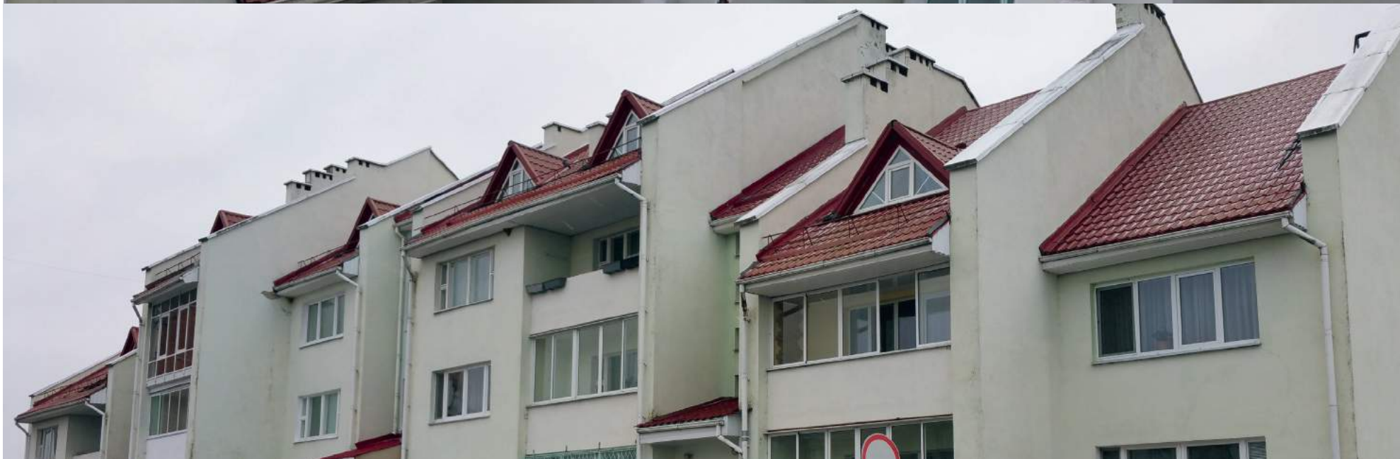
Рис.6: Элемент фасада здания Место соединения крыши и наружной стены
